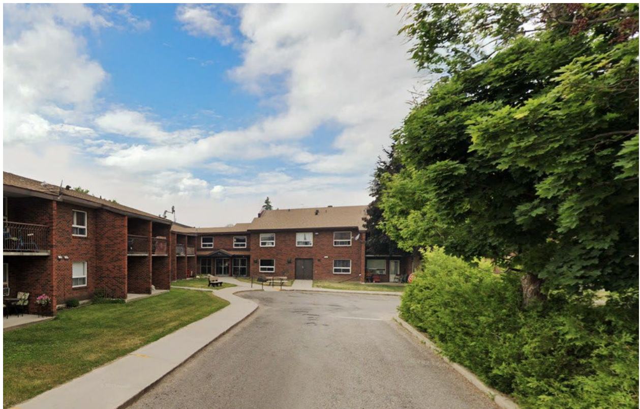
Logements situés au 236 Hall Ave.
